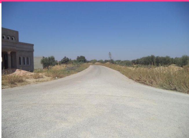
تهيئة وتعبيد طريق بئر زميت عدد 1
